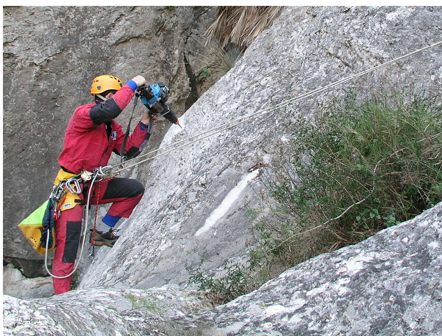
▲ Instalación mediante taladro de gasolina.
