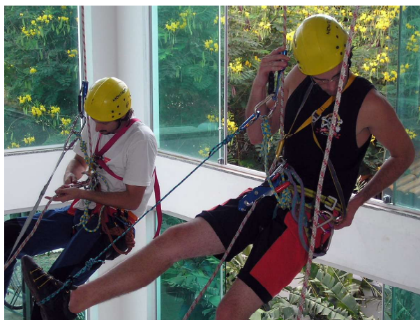
▲ Realizando el cambio de ascenso a descenso.
