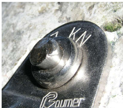
▲ Detalle de la varilla de expansión una vez colocado.
