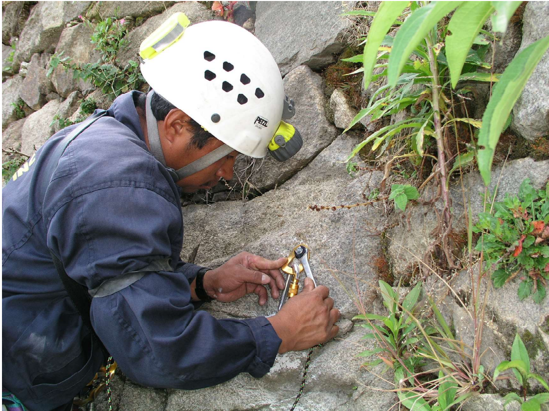
▲ Colocación de un anclaje.
