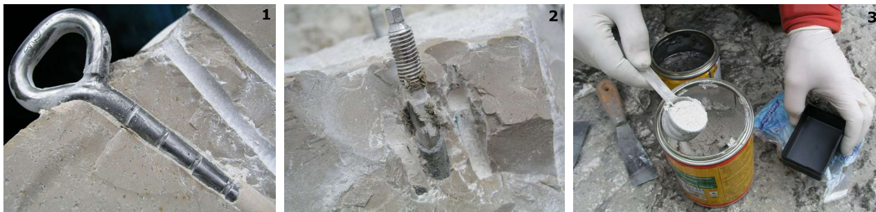
▲ Detalle de dos anclajes químicos instalados y de la mezcla de la resina y el catalizador.
