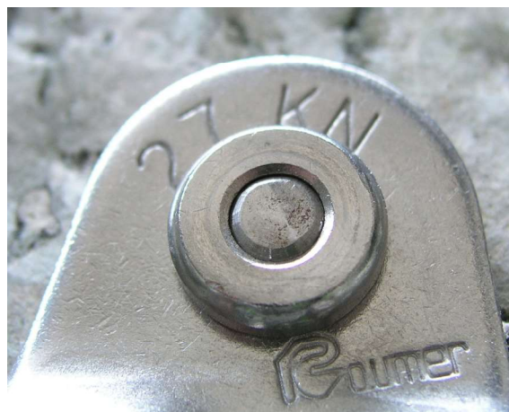
▲ Detalle de la varilla de expansión una vez colocado.
