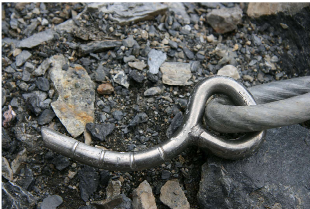
▲ Anclaje químico sometido a una fuerza excesiva que lo ha deformado y doblado.
