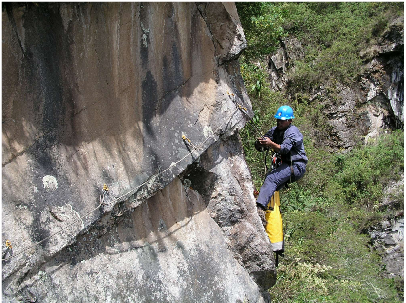
▲ Instalación de una vía que dispone de un largo pasamanos.
