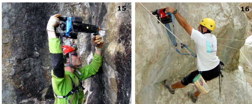
▲ Instalación mediante taladro de gasolina (15) y de batería (16).
