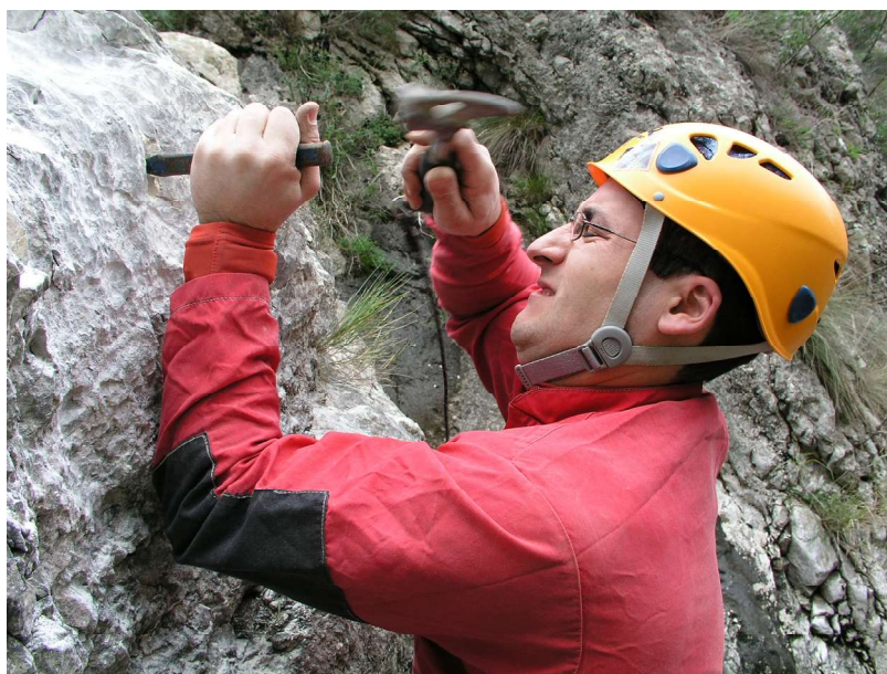
▲ Abocardado del orificio para la colocación de un tensor asimétrico.
