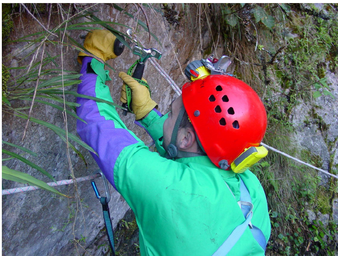
▲ Instalación de los anclajes de una cabecera.
