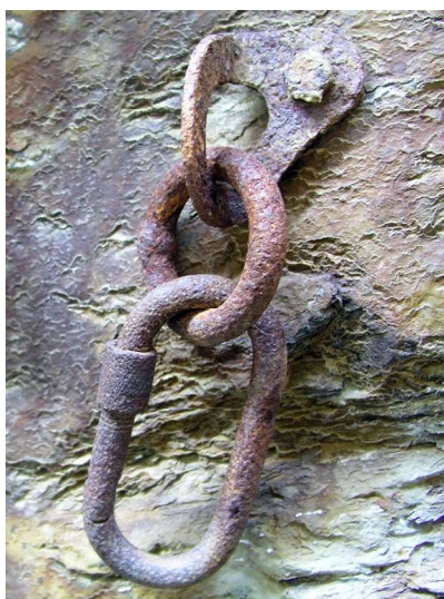
▲ Anclajes en malas condiciones debido a la corrosión y a una defectuosa colocación.
